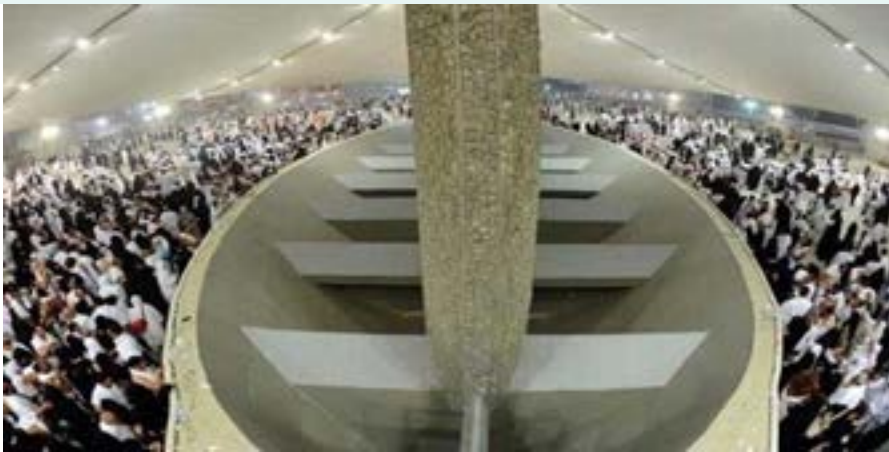
أنظمة آلية الحصى بسبور ضخمة تسحب الحصىات الموجودة، بعد تجميعها في حوض الجمرات الثلاثة،
